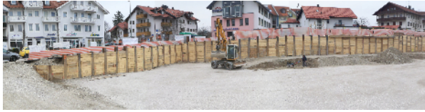
Berliner Verbau entlang einer Straße
