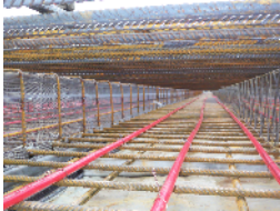
Bodenplatte mit Betonkernaktivierung
