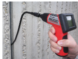
Blick hinter die Fassade
