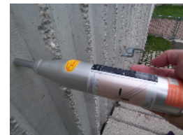
Messung der Betonfestigkeit
